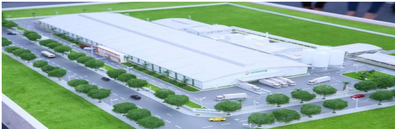
Toàn cảnh Nhà máy Sữa Đậu nành Vinasoy Bắc Ninh
